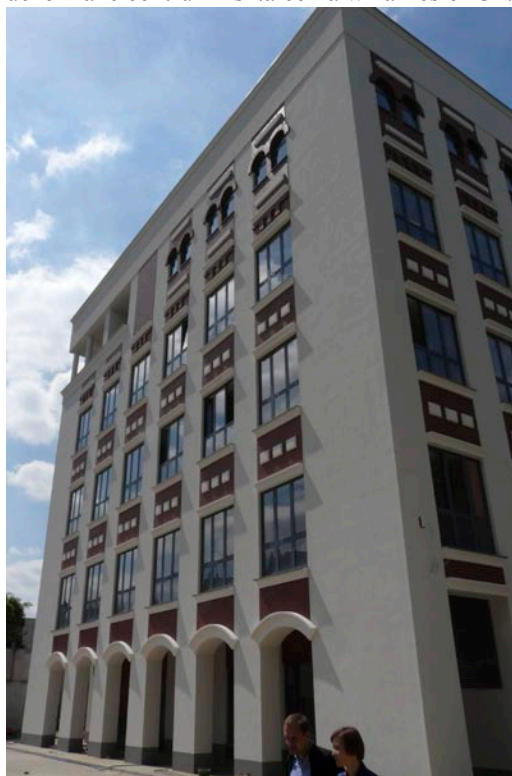
Budynek CTI PŁ, foto: P. Sękałski
