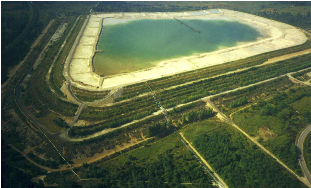
Fot.1. Ansicht des Absetzbecken
