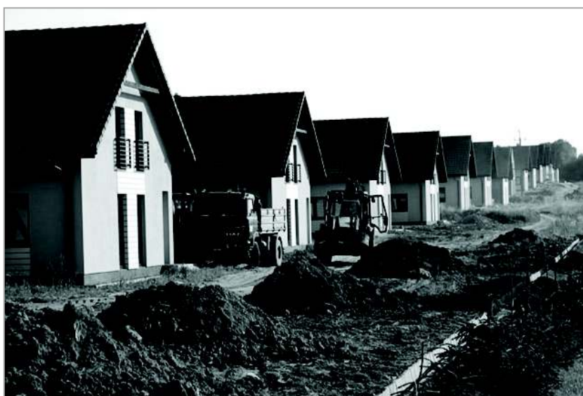
Fot. 26. Budowa osiedla składającego się z kilkunastu identycznych domów. Przykład stosunkowo nowego zjawiska w przestrzeni podmiejskiej. Dotychczas firmy deweloperskie niezbyt często podejmowały tak duże inwestycje – osiedle Budziwój
